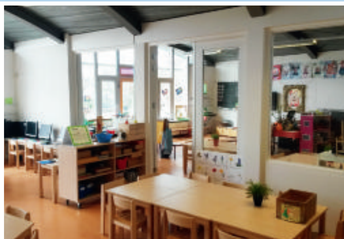
De muur tussen twee kleuterlokalen is vervangen door een glazen wand.
